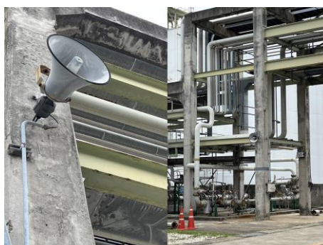
ภาพที่ 2.2-17ก ระบบสัญญาณเตือนภัยในบริเวณ พื้นที่ก่อสร้าง
