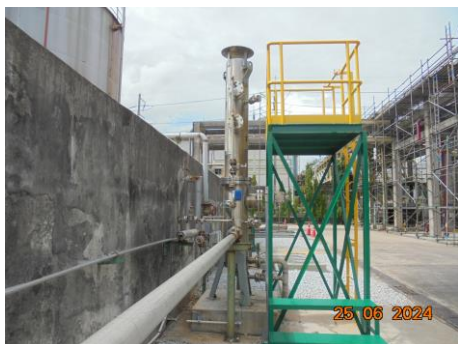
ภาพที่ 2.2-5ฯ Seal Pot บริเวณถังเก็บกรดอะซิติก
