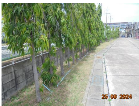
ภาพที่ 2.2-19x ท่อส่งน้ำทิ้งหลังการบำบัดน้ำมารดน้ำต้นไม้
