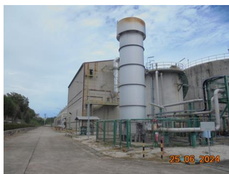
ภาพที่ 2.2-18x หอเผา (Flare) และรั้วกั้นรอบหอเผา
