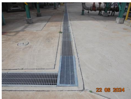
ภาพที่ 2.2-26ข รางระบายน้ำฝนปนเปื้อนภายในโรงงาน
