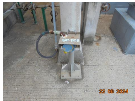
ภาพที่ 2.2-52x Gas Detector
