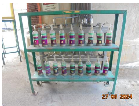
Acetic Acid On-line Detector ของโรงผลิตที่ 3
