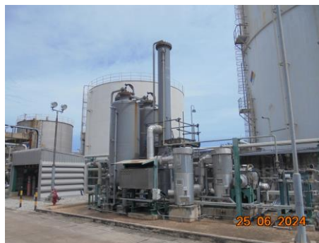
ภาพที่ 2.2-6ฯ หอดูดซับสารอินทรีย์ระเหยง่าย (VRU)
