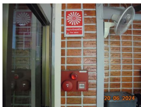
ภาพที่ 2.2-43 ข อุปกรณ์เตือน-ชี้อัต (Alarm)
