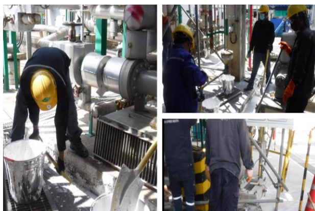
ภาพที่ 2.2-25ข การขุดลอกรางระบายน้ำฝน
